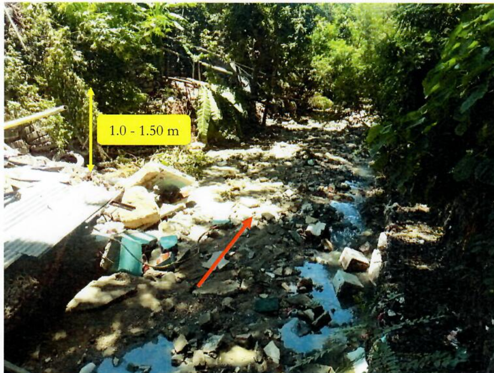
Fotografía N°3. Longitud de 15 m de talud revestido con plástico y con llantas y nivel máximo alcanzado por de flujo de la quebrada.
