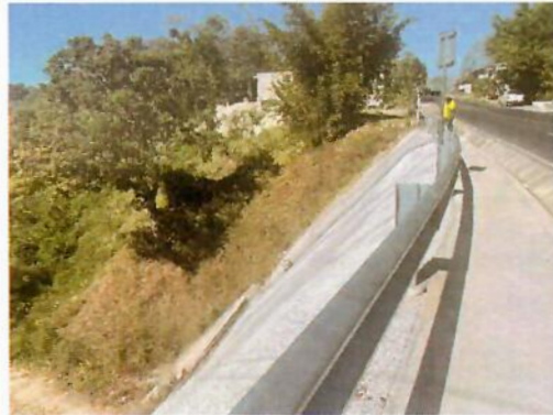
Costado Oriente se observan los taludes
