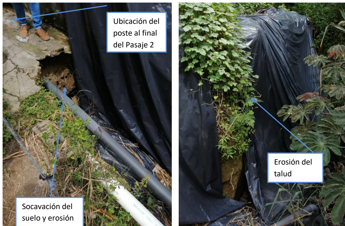
Fotografía 4. Estado actual del final del Pasaje 2.
