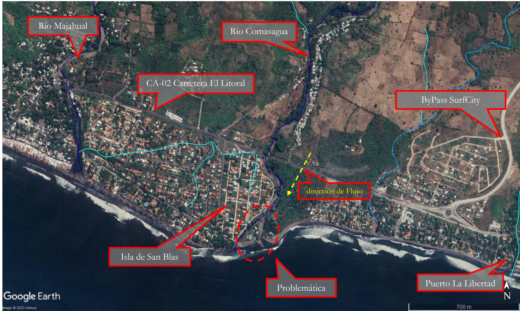
Imagen N° 1. Esquema de ubicación general de problemática por erosión de margen derecho de Río Comasagua, Isla de Blas, La Libertad. Fuente: Imagen de Google Earth , julio 2023.
