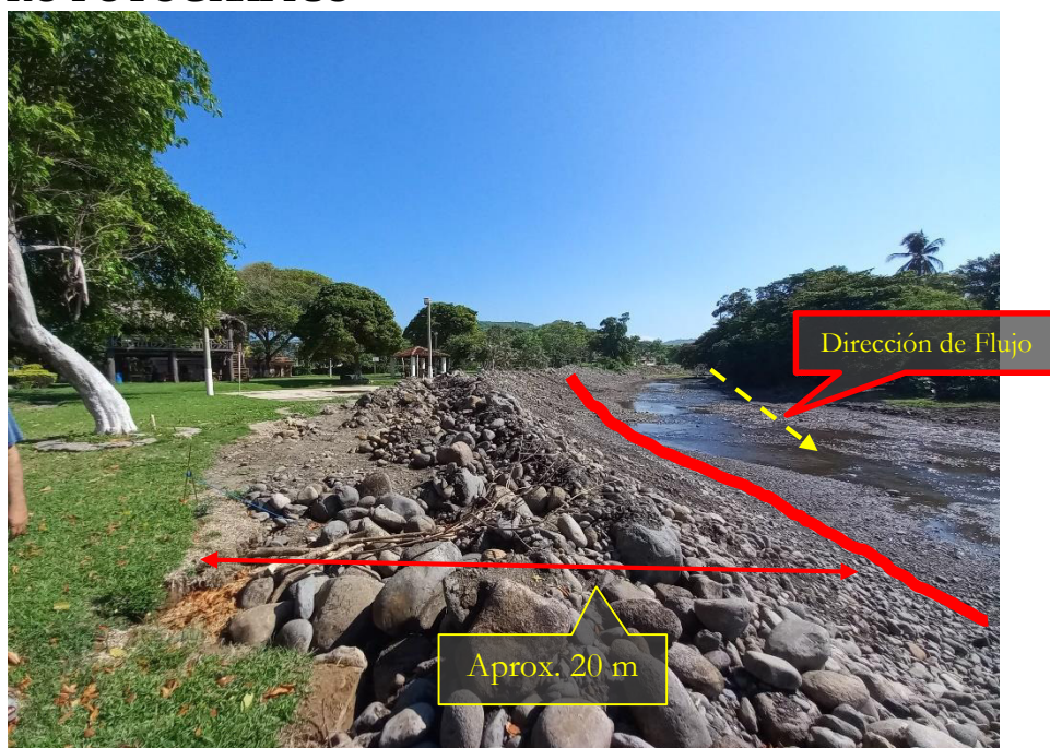
Fotografía N° 1. Zona de erosión hacia margen derecho de Río; línea roja, muestra margen en 2018
