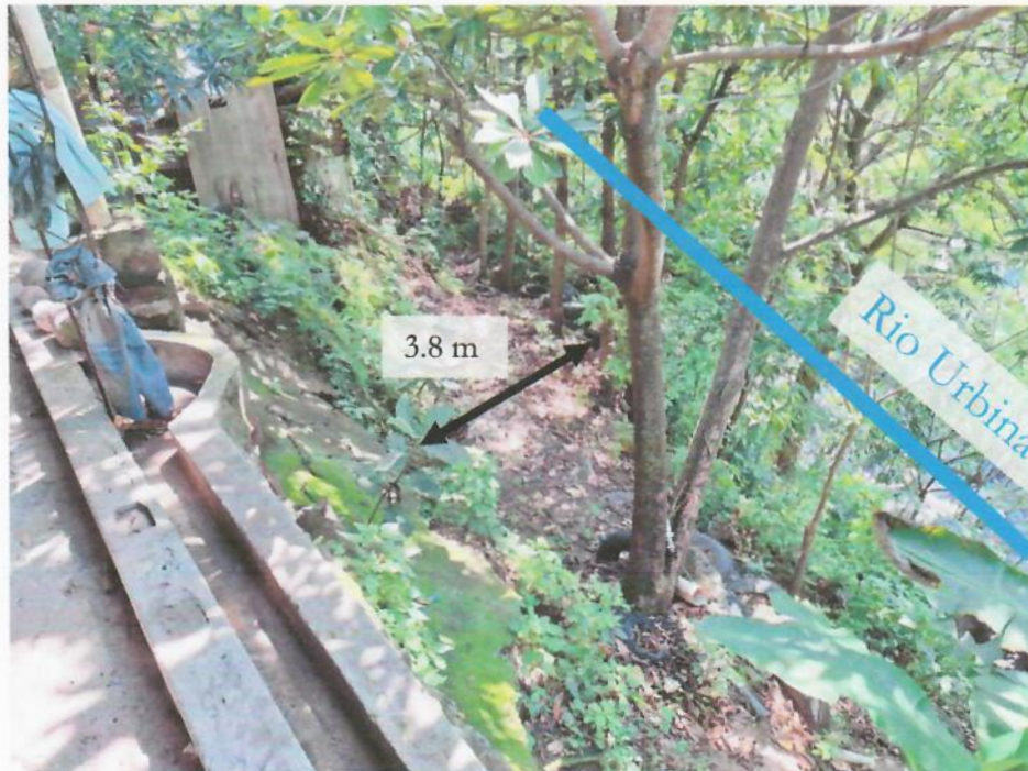
Imagen 3. Vista del perfil de talud junto al Río Urbina
