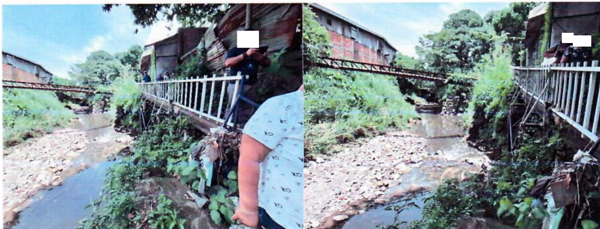
Imagen 9. Sector donde se necesita muro de protección en margen derecho
