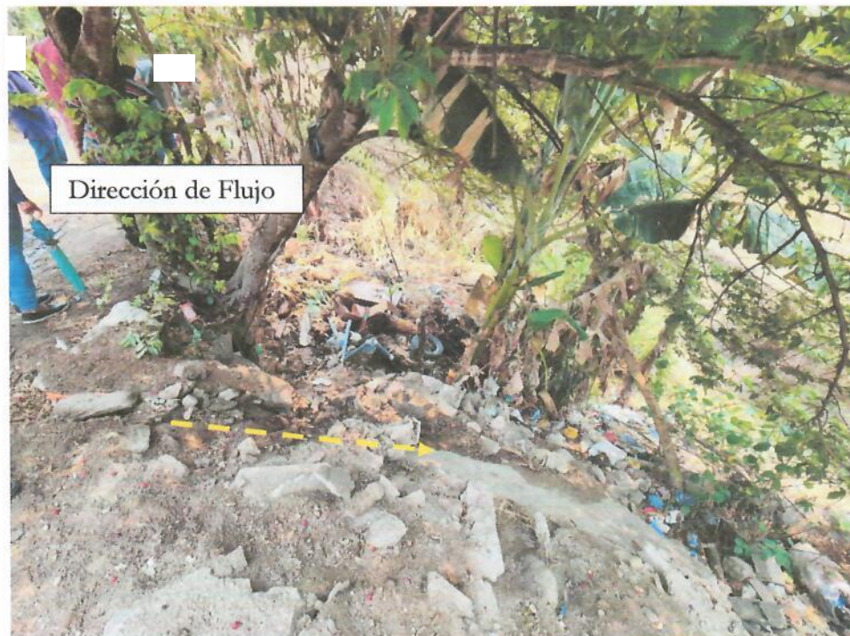
Fotografía 7. Relleno con ripio, tierra y escombros realizado por la Comunidad.
