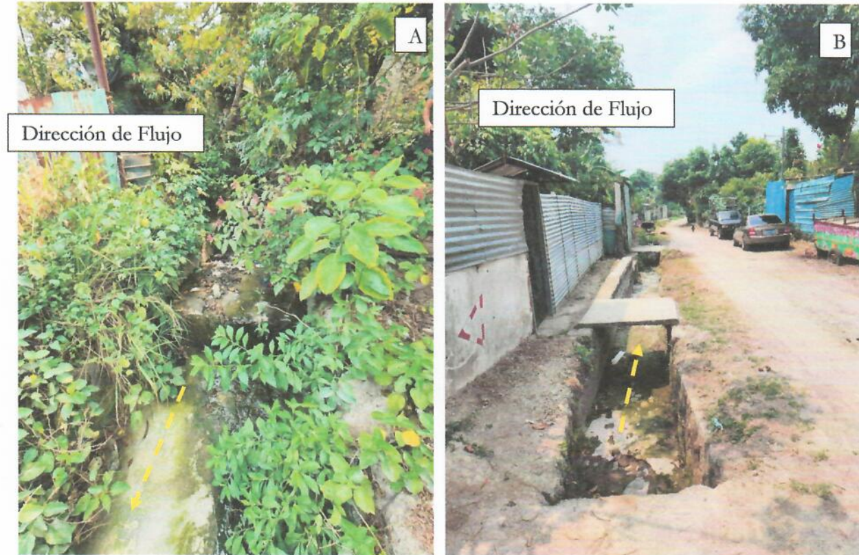
Fotografía 3. a) Derramadero y canaleta identificado en la zona, b) Sección hidráulica inicial de la canaleta.
