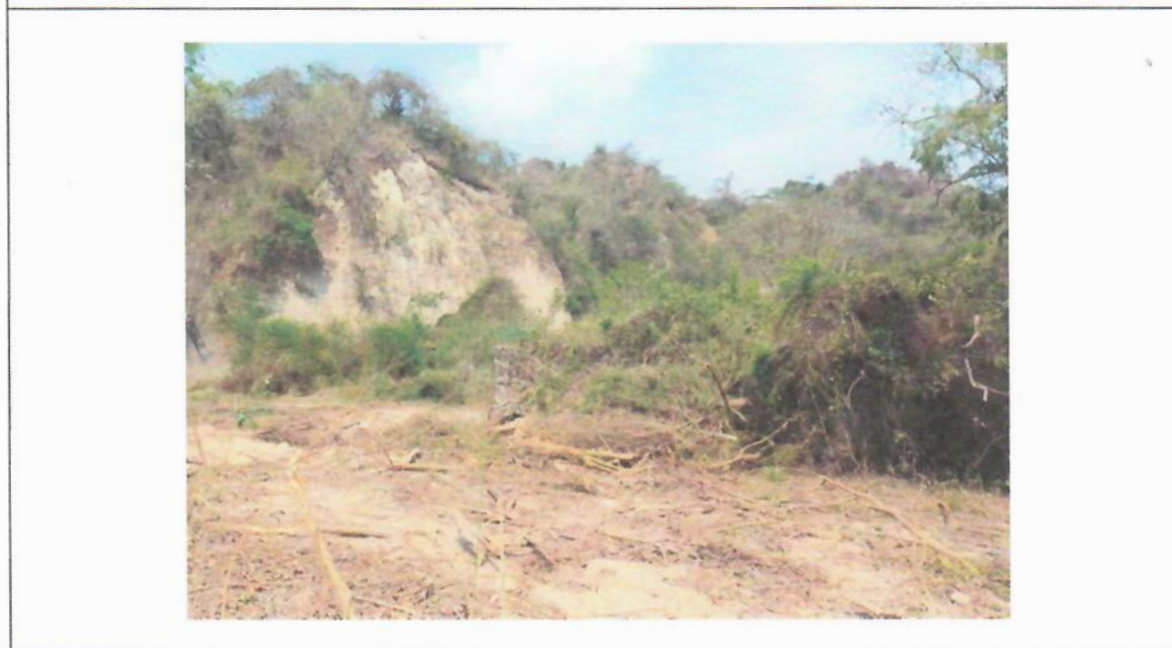
Cárcava adyacente a la Fuerza Aérea de El Salvador, antes de ser intervenida por las obras complementarias, donde se ha estabilizado la erosión del talud.
