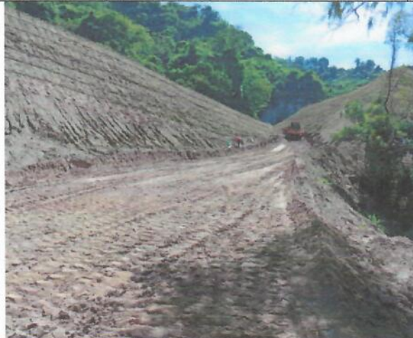
Relleno de cárcava en el sector de la Fuerza Aérea, donde se han conformado la estabilización de taludes.
