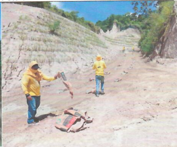
Conformación de taludes y estabilización de los mismos, en el sector cercano a la Residencial Santa Lucía.
