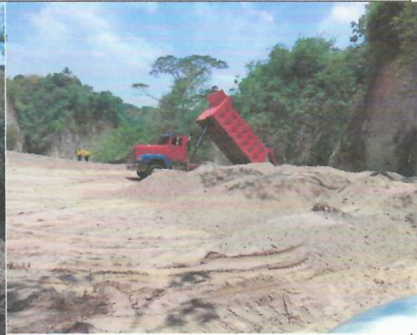
Relleno de cárcava en el sector de la Fuerza Aérea, donde se han conformado la estabilización de taludes.
