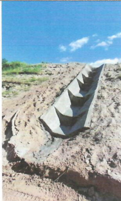
Canaletas para el drenaje de corrientillas, las cuales serán canalizadas desde la corona del talud, con la finalidad de prevenir erosiones.
