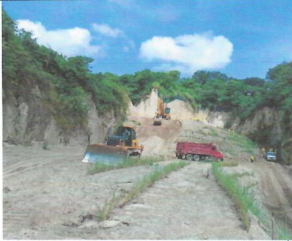
Conformación de taludes y estabilización de los mismos, en el sector cercano a la Residencial Santa Lucía.
