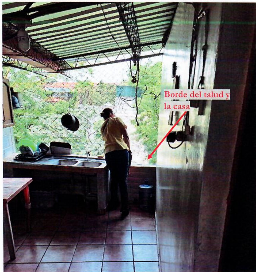
Imagen 2. Vista de la pared posterior de la casa sobre la corona del talud
