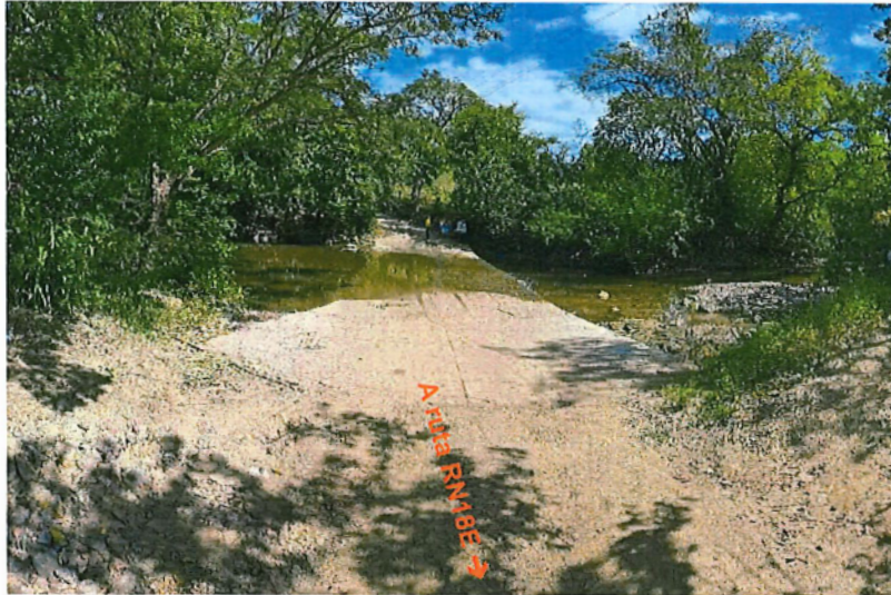
FOTO 1, Obra de pasa existente, badén de concreto de 30.00 m de largo por 6.50 m de ancho
