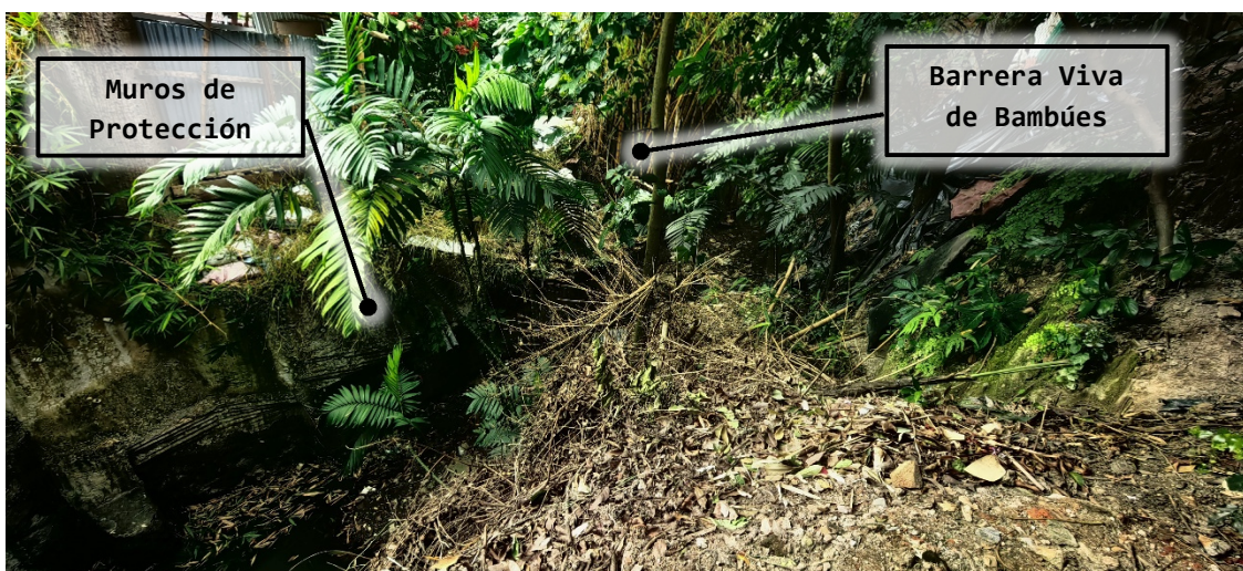
Fotografía N° 3. Presencia de muros de protección y barreras vivas de bambúes en margen izquierda de quebrada, aguas abajo de obra de paso y frente a Lote N°19.
