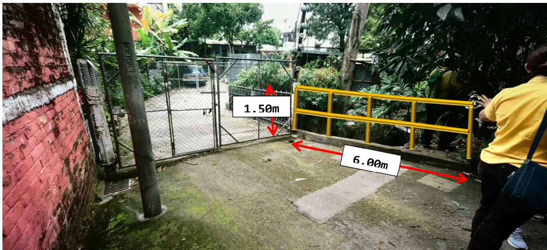
Fotografía N° 5. Colocación de barandal de protección propuesto, en proximidad con Lote N°18.
