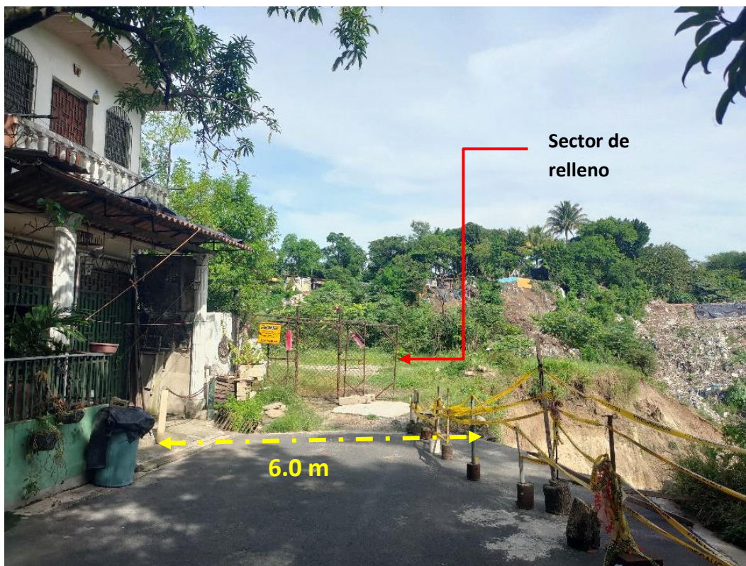
Imagen 2. Estado actual de Final de Calle Veracruz y Pasaje San Miguel.
