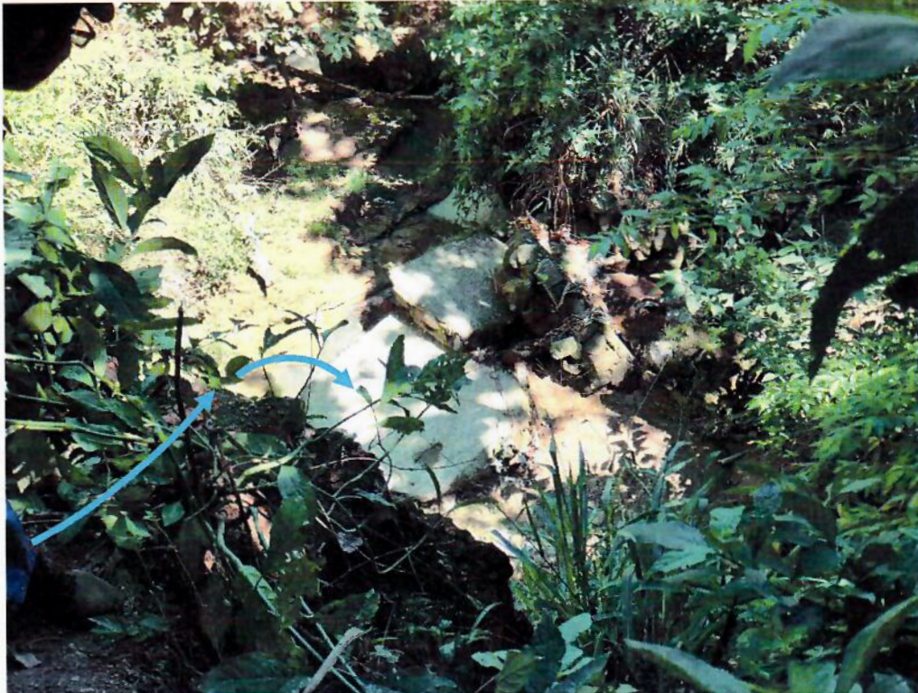
Figura 4. Colapso 2. A 75 metros aguas abajo.
