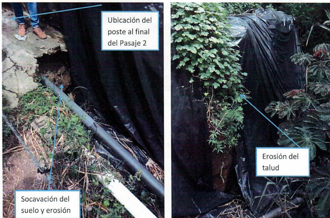
Fotografía 4. Estado actual del final del Pasaje 2.
