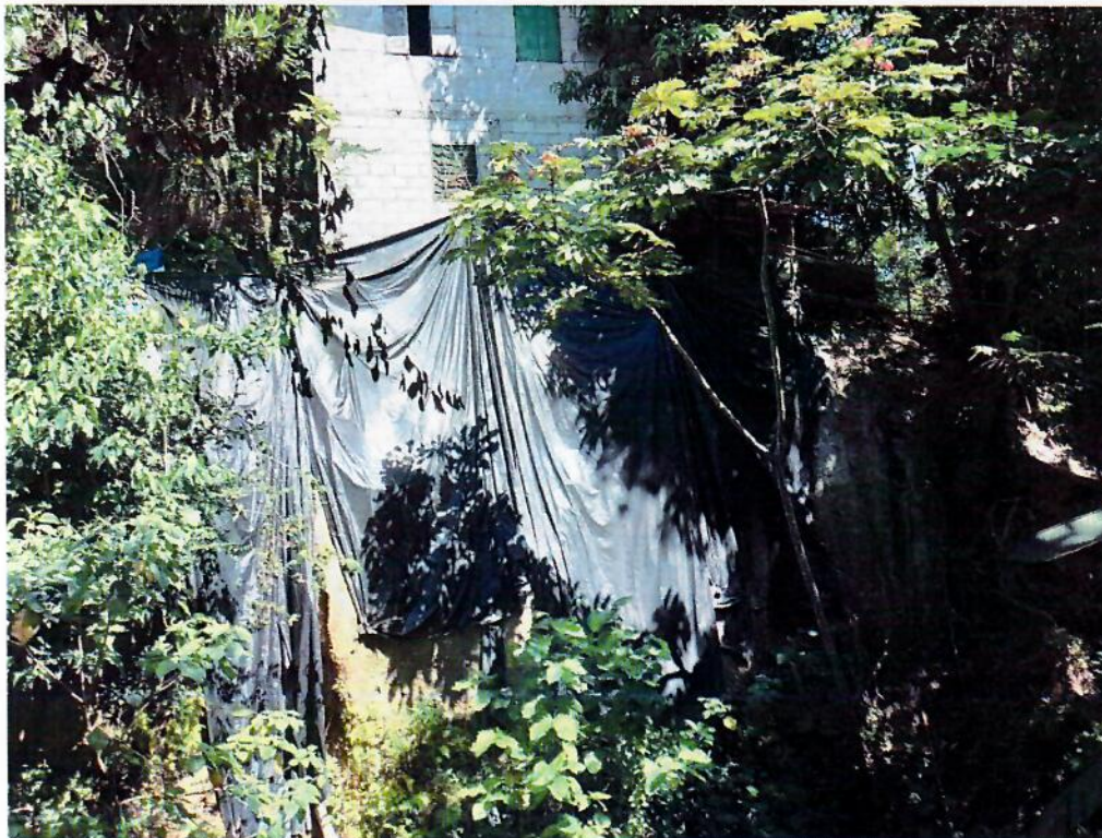
Figura 3. Vista general de talud vertical en margen izquierdo.
