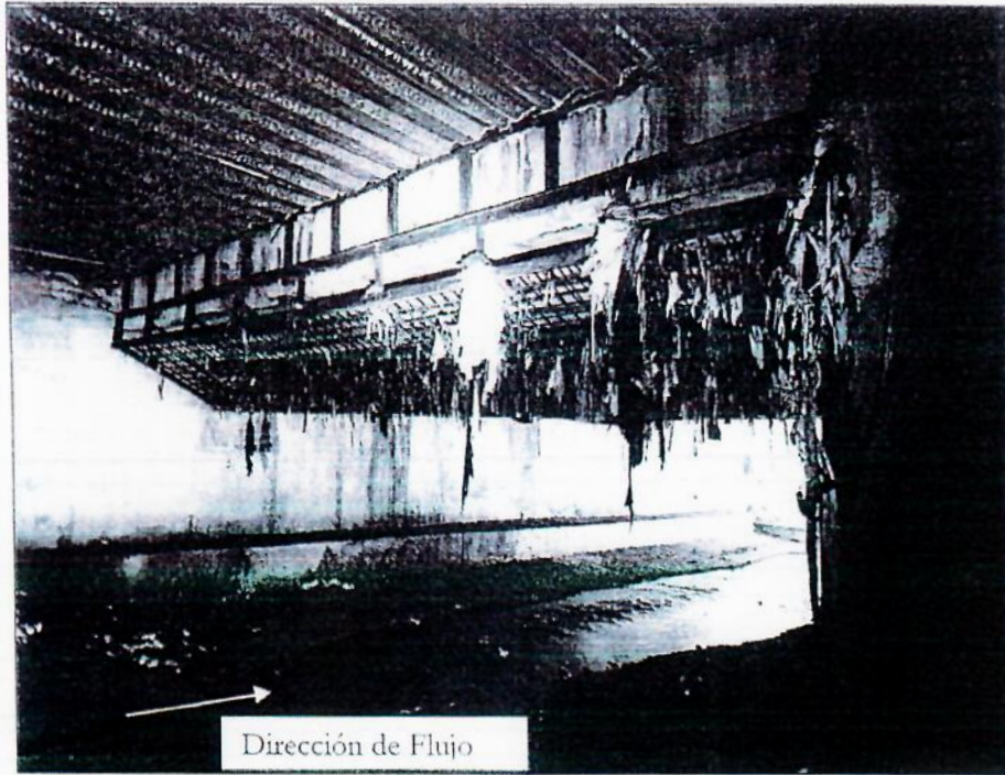
Fotografía 5. Tramo de sección de estructura de puente, sección hidráulica rectangular.
