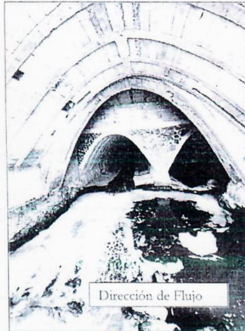
Fotografía 3. Cambio de sección bóveda doble.
