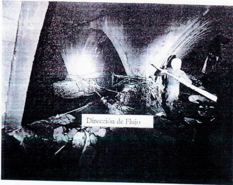
Fotografía 9. Cambio de sección de bóveda tramo colindante a Canal 12, sección de semi arco triple.
