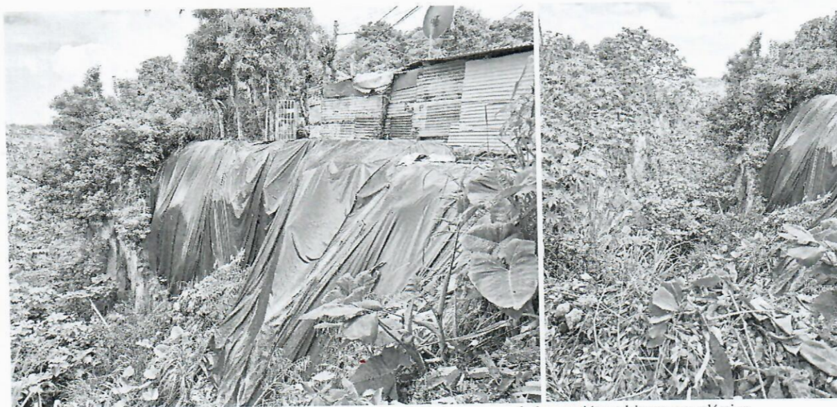
Imagen 4. Vista de taludes laterales de la descarga y de la porción cubierta con plástico
