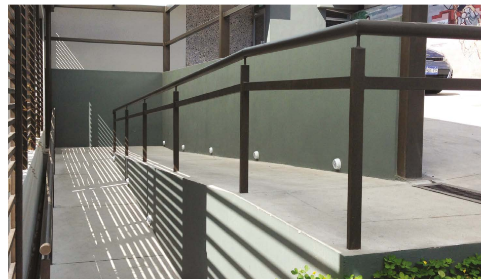
Rampa de acceso
