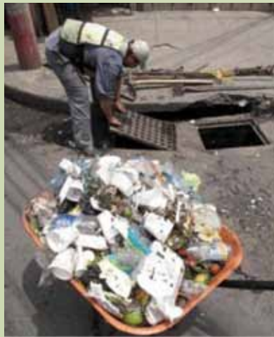
IMAGEN No. 3. Limpieza de tragantes por parte de los empleados municipales.
