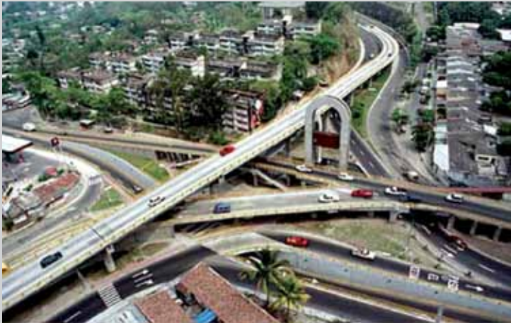
IMAGEN No. 1. Muestra del paso a desnivel más complejo del AMSS (Hermano Lejano), y que deja clara la tendencia del diseño vehicular sobre otros modos de transporte no motorizados,
