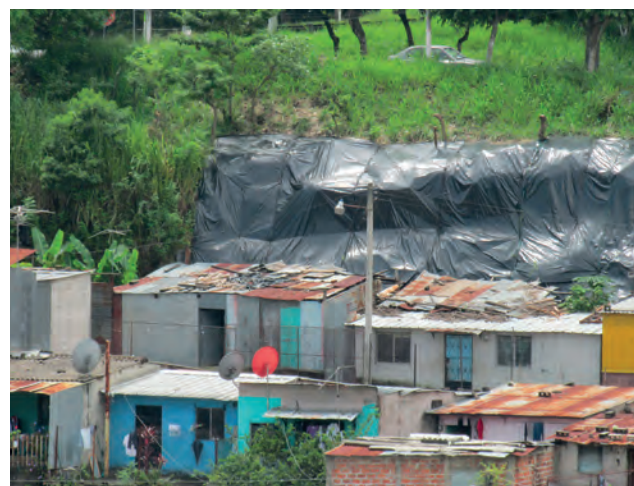
Viviendas en Asentamientos Urbanos Precarios AUP - Comunidad Modelo II. Municipio de San Salvador.
