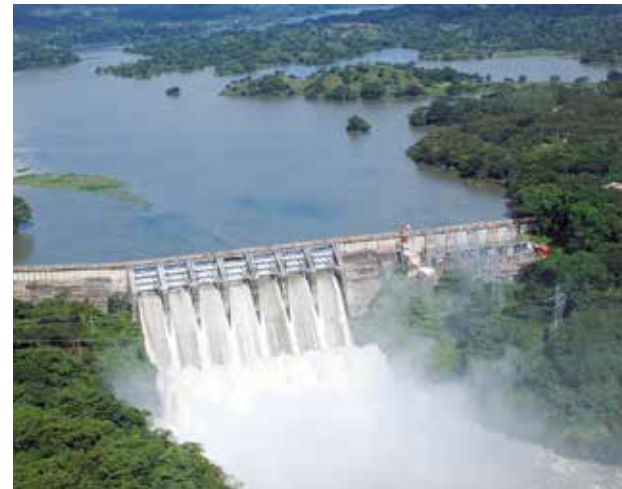
Central Hidroeléctrica 5 de Noviembre, Cabañas
