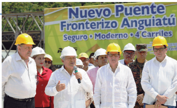
El presidente Sánchez Cerén verificó los avances en las obras de construcción del puente binacional en la frontera Anguiatú.
