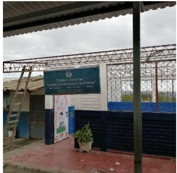
Reparación de Techo de escuela Caserío Los Chirinos, Cantón Animas.
