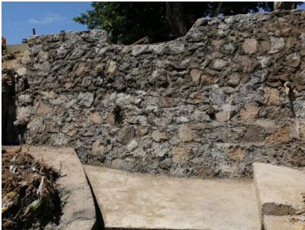
Construcción de muros, Cantón San Francisco
