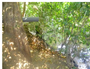
Fotografía No. 20: Aguas Grises de gasolinera, Contaminación del Río Copinula
