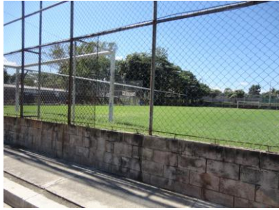
Fotografía No. 7: Polideportivo municipal
