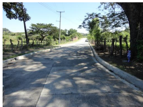
Fotografía No. 1: Calle al Cementerio Jardines de San Pablo
