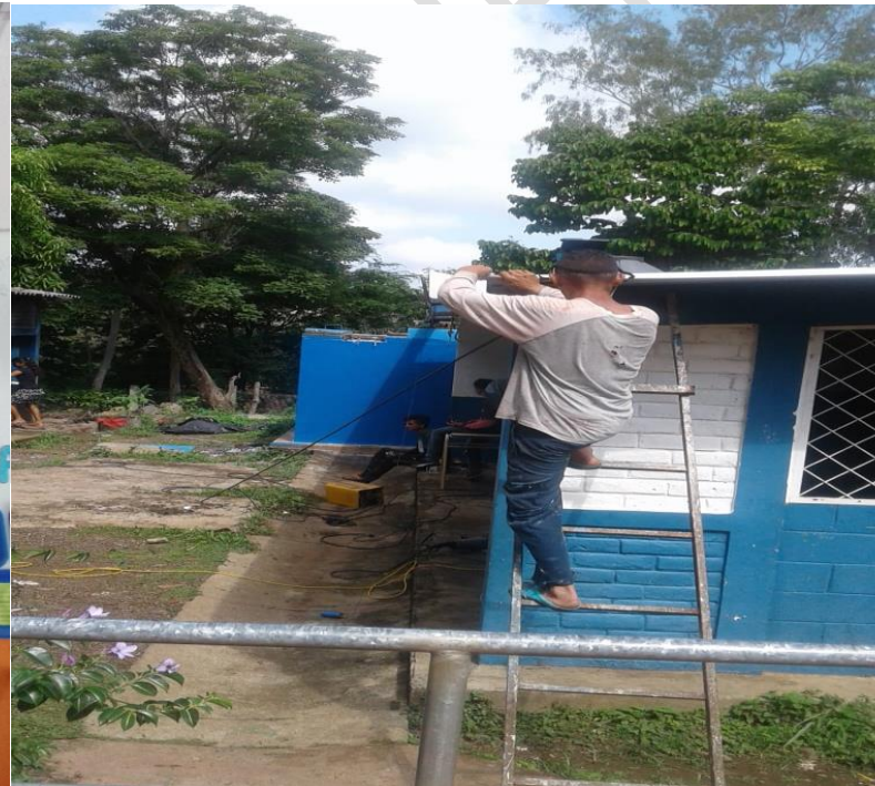
Instalación de Canales en C.E. Campana Estacion de desechos solidos C.E. Las Pavas Estacion de desechos solidos C.E. Las Pavas
