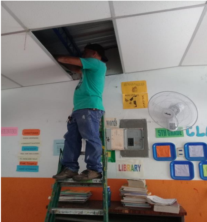
Instalacion de ventiladores en C.E. El Transito Estacion de desechos solidos C.E. San Isidro Estacion de desechos solidos C.E. San Isidro
