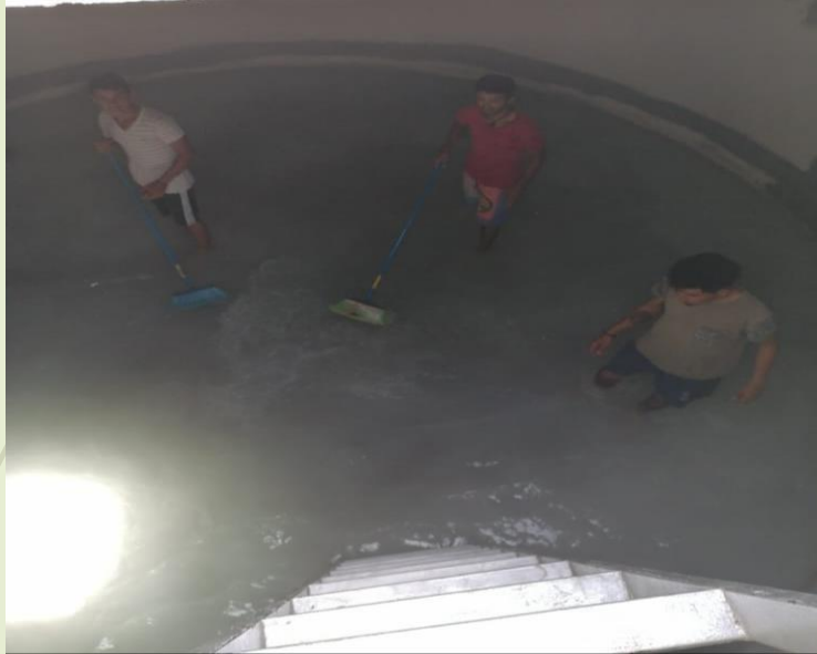
Lavado de tanques de almacenamiento
