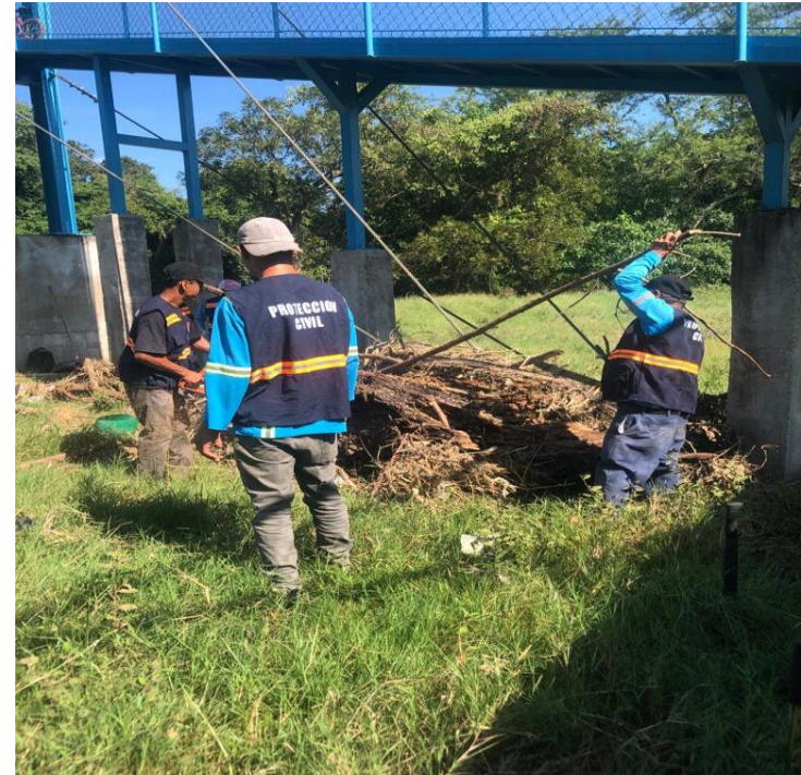
Retiro de escombros acumulados en puente hamaca de los rincones, Valle Mesas.
