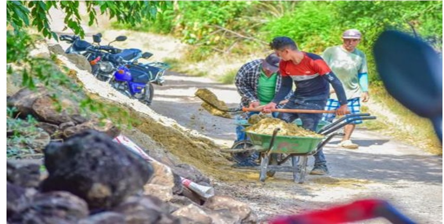
Reparación de calle en caserío El Conacastillo, cantón San Isidro
