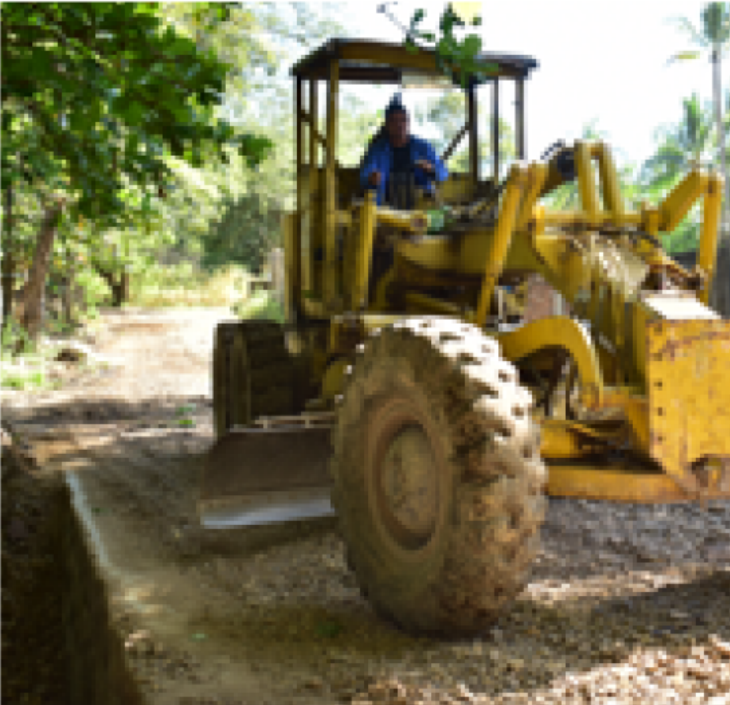
Balasteo de calle en Caserío Apantillos
