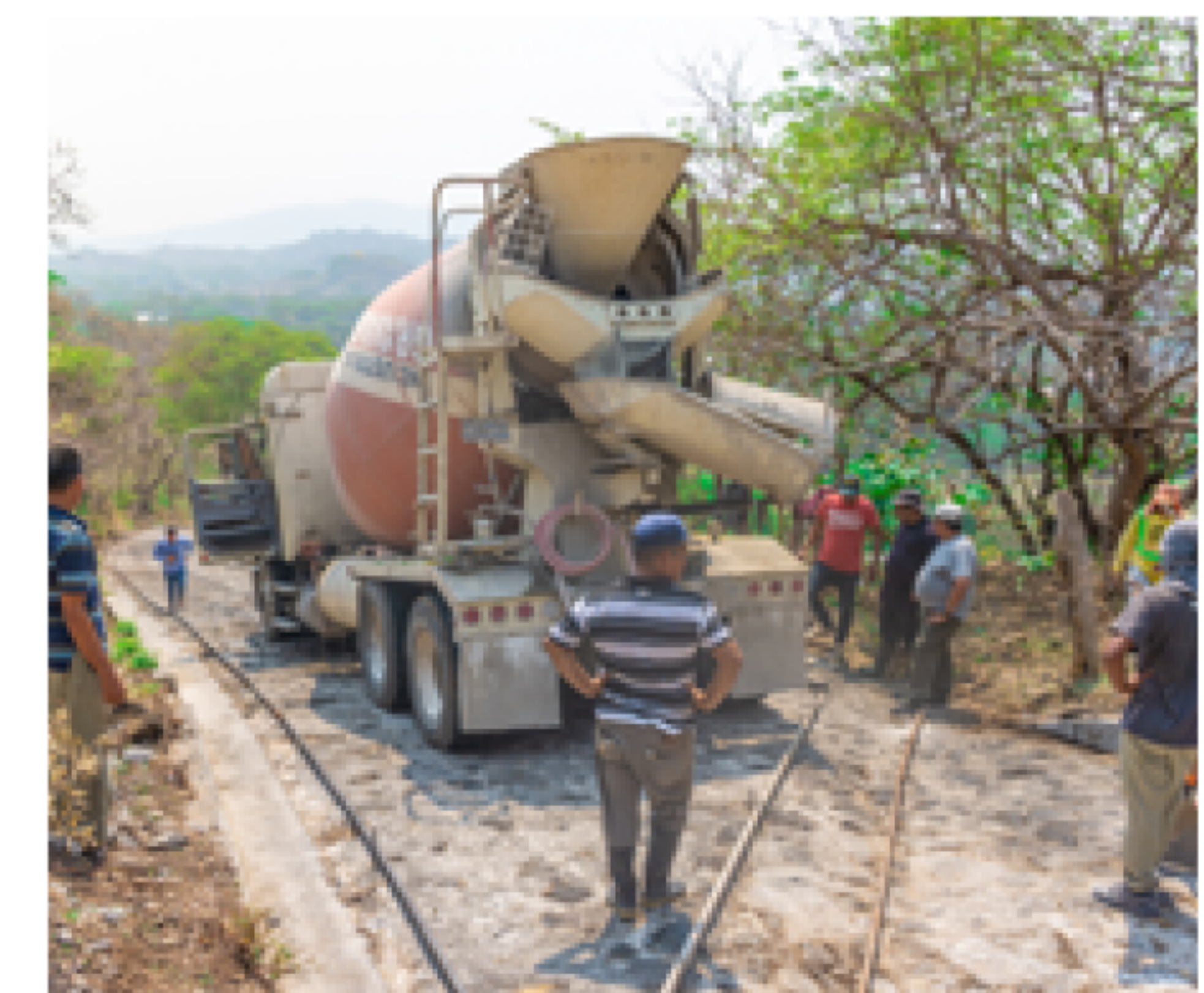
Fraguado de tramo de calle en Plan del Amate
