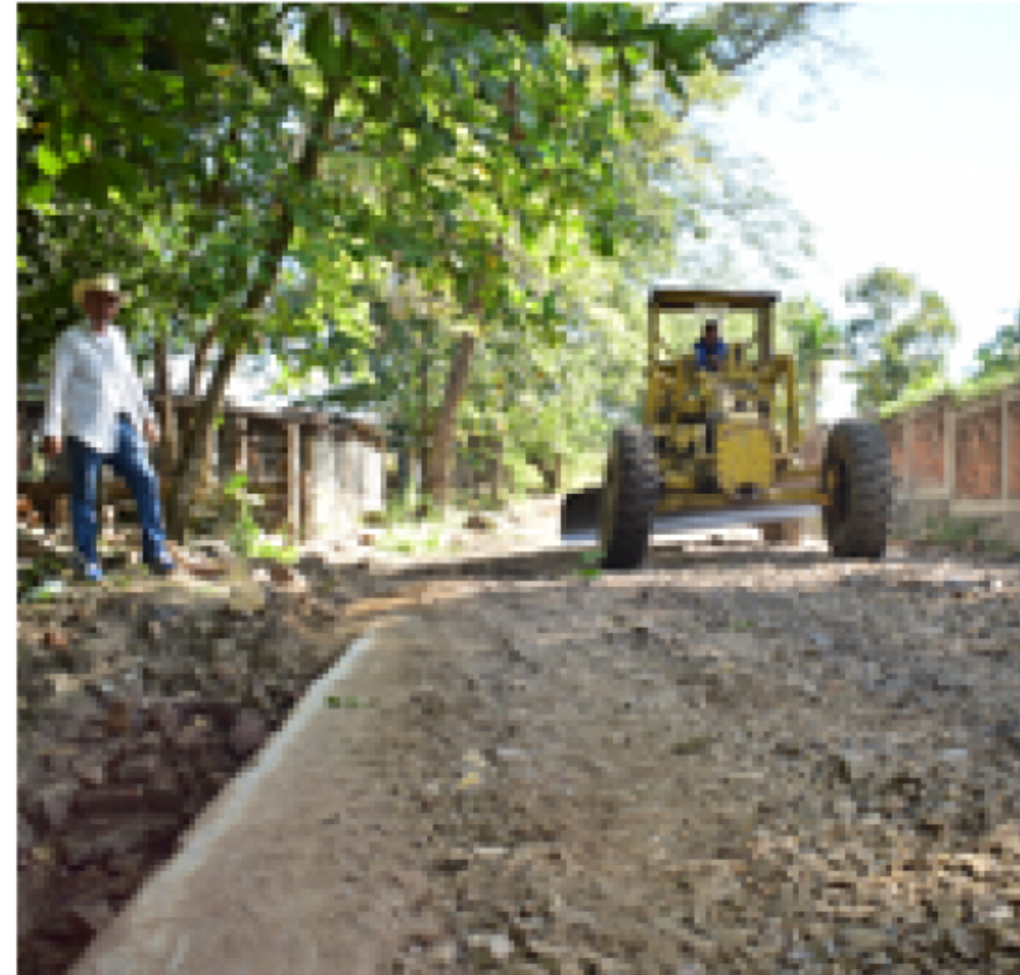
Balasteo de calle en Caserío Apantillos
