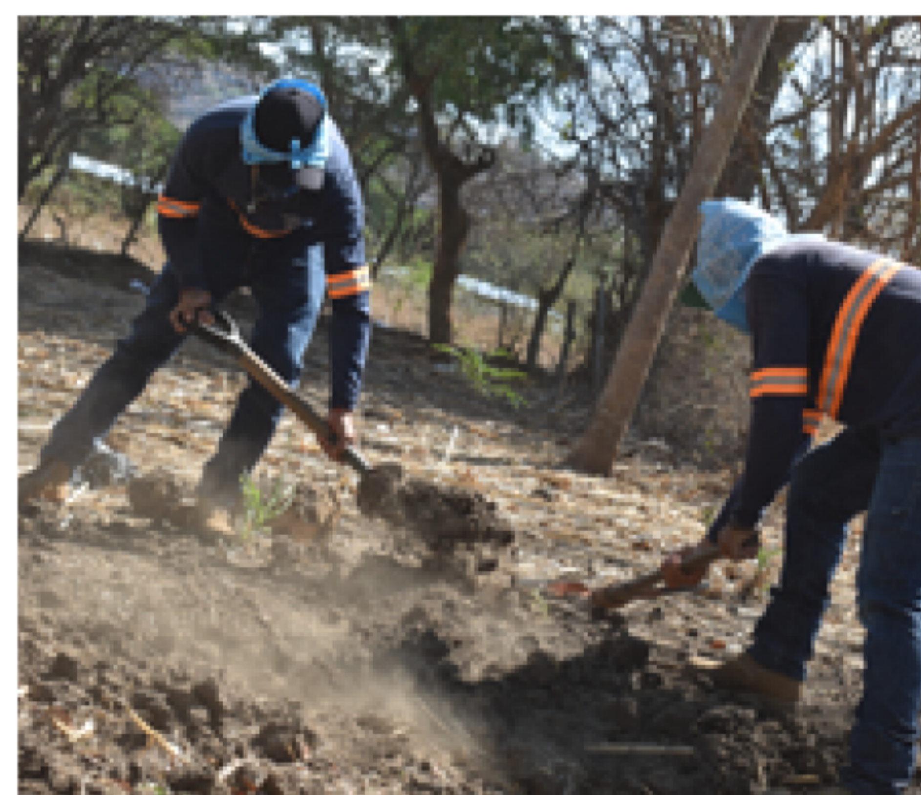
Extensión de 200 mts de agua, Caserío Barillas
