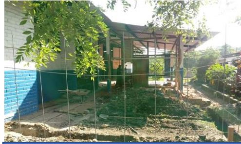
REMODELACION DE C.E. CANTON EL RODEO
