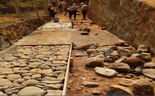
CONCRETEADO EN CRIO. LOS ANDRADE, EL LIMON
