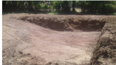
CONSTRUCCION DE RESERVORIOS
