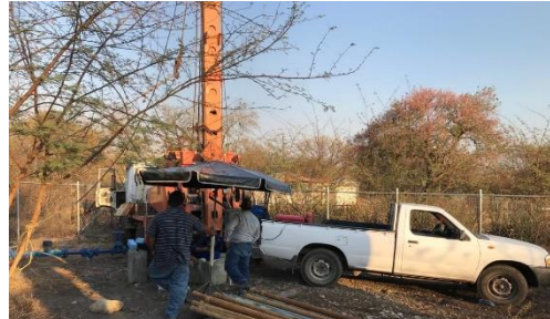
LIMPIEZA DE POSO EN AREA URBANA
