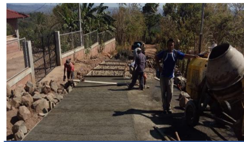
CONCRETEADO EN CRIO. EL GUARUMAL, EL LIMON
