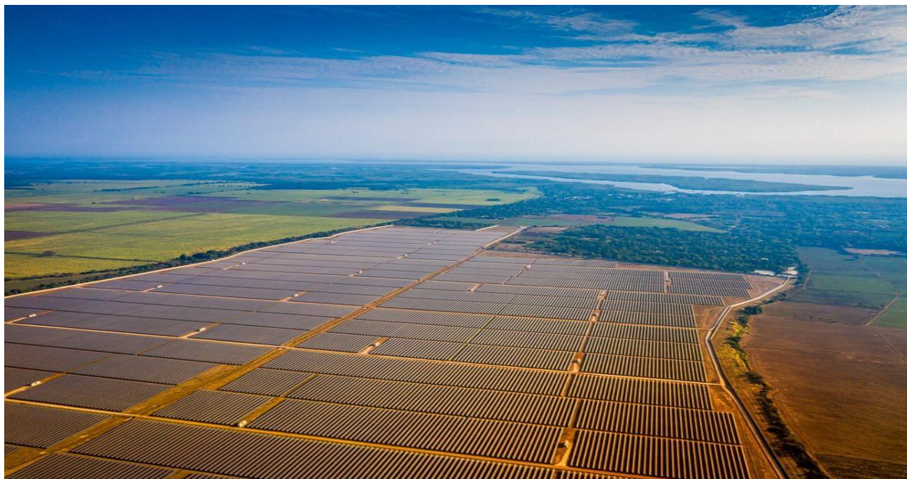
PLANTA FOTOVOLTAICA DE CAPELLA SOLAR CAPACIDAD INSTALADA 100MW
