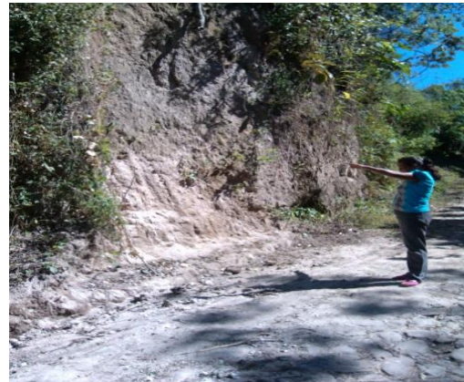
PR-20. Susceptible a derrumbe Calle a San José El Sitio
