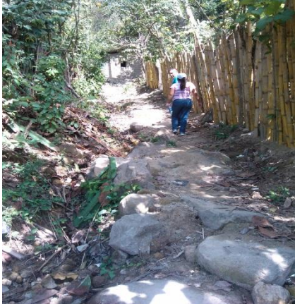
PR-11. Vivienda en riesgo por deslizamiento y pasaje con pendiente se inunda en invierno Caserío Los Peña, Tablón Abajo
