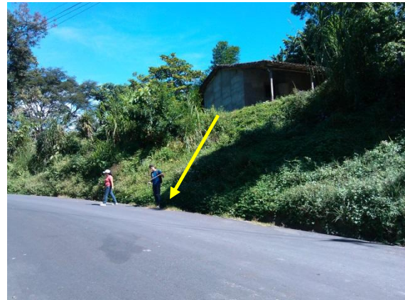
Susceptible a derrumbe calle a Tenancingo casa se encuentran en riesgo
