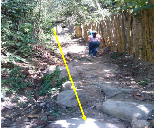
Vivienda en riesgo por deslizamiento y pasaje con pendiente se inunda en invierno Caserío Los Peña, Tablón Abajo
