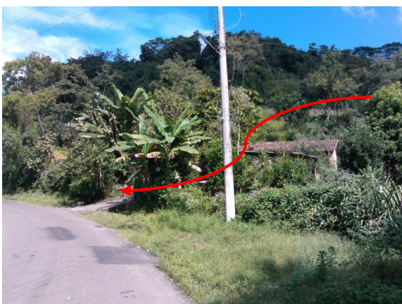
Deslizamientos Caserío Los Peña, Tablón Abajo, 3 viviendas y calle en riesgo
