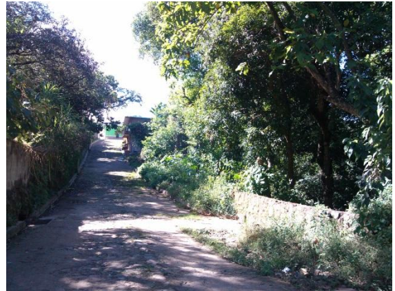
PR-35. Contaminación y estancamiento aguas negras Barrio La Democracia, Calle Principal quebrada El Guayabo
