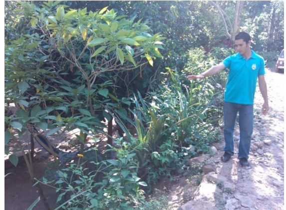
PR-25. Inundación por escorrentía agua Lluvia, vivienda nivel bajo de calle cantón Copalchan
