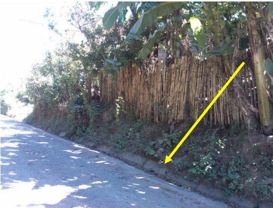
Susceptible a derrumbe calle a Tenancingo casa se encuentran en riesgo
