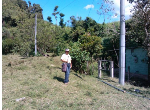
PR-14. Se inunda Terreno donde se localiza las Instalaciones y equipo del Pozo captación de agua comunitaria de Rosario Tablón
