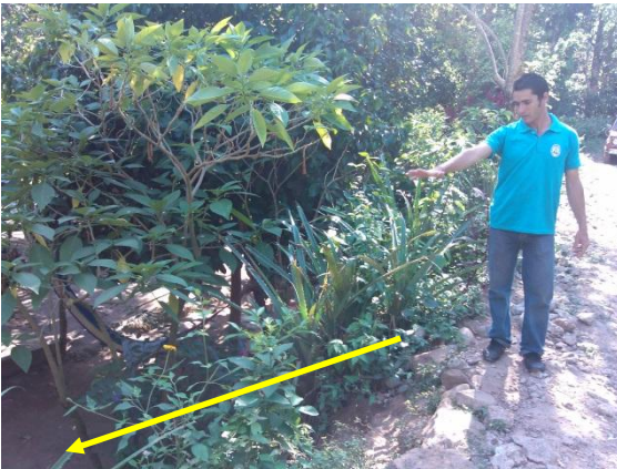
Inundación por escorrentía agua Lluvia, vivienda nivel bajo de calle cantón Copalchán.
