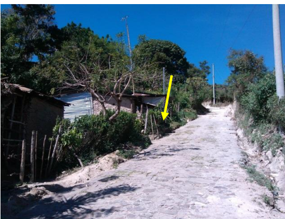
Susceptible a deslizamiento Calle a San Jose El Sitio
