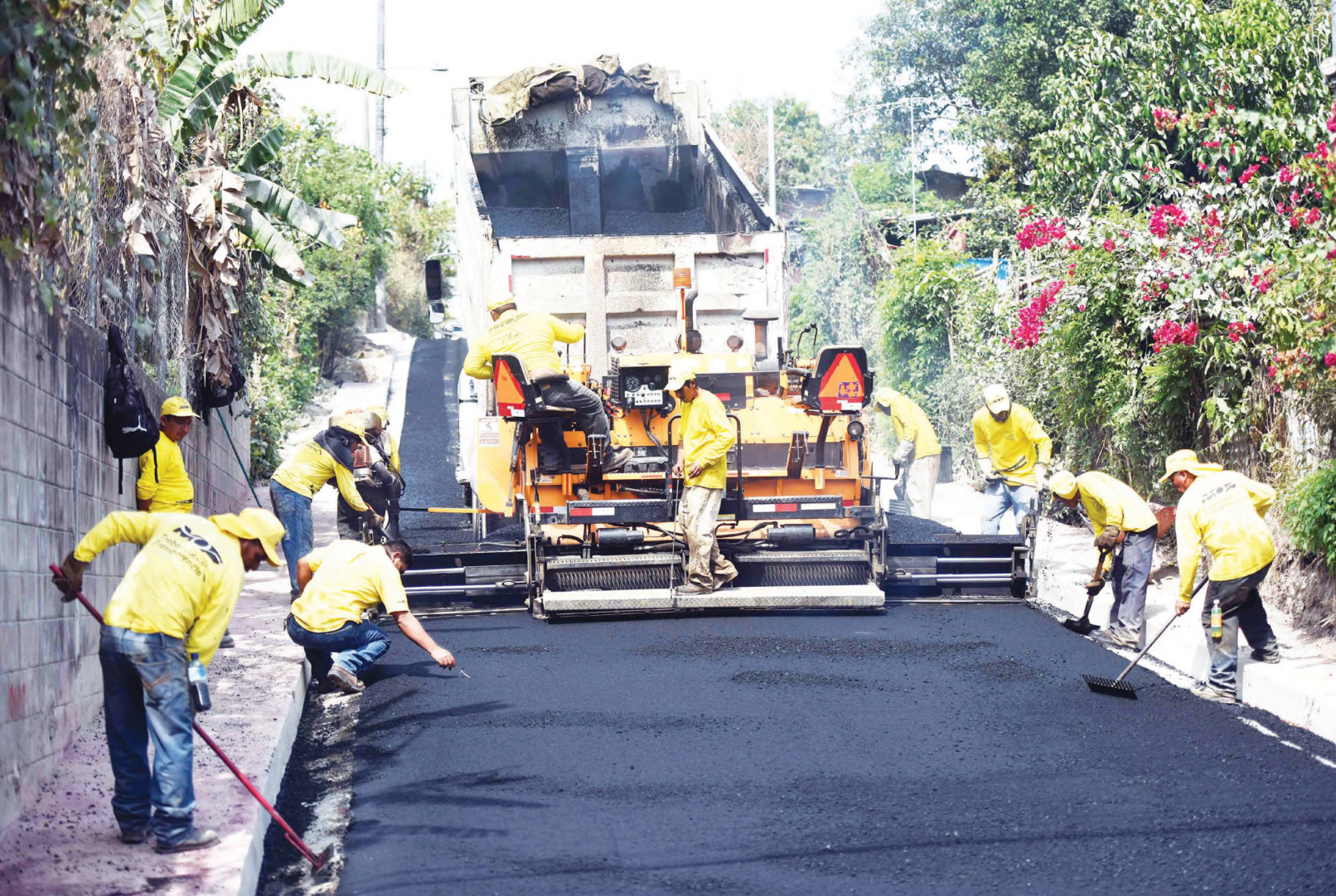
Mejoramiento de caminos en comunidad El Castaño, Soyapango.
