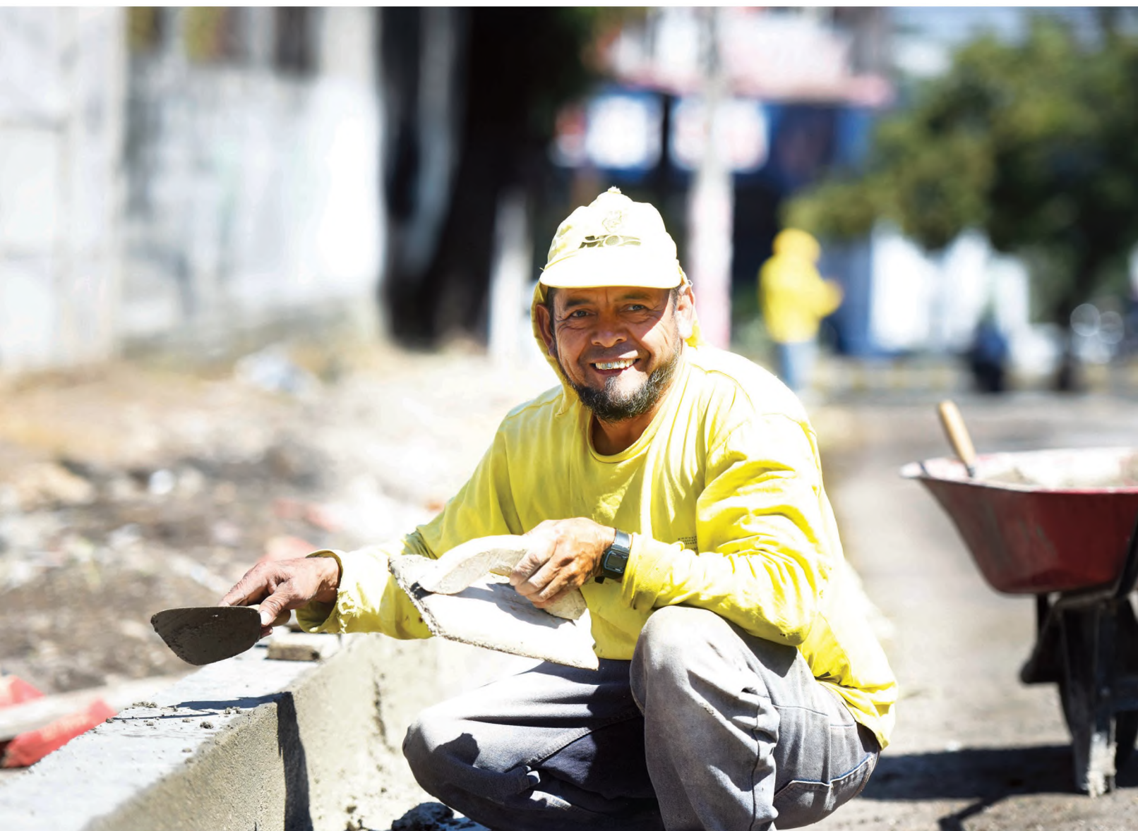
Construcción de drenajes, parte de los programas de desarrollo integral.
