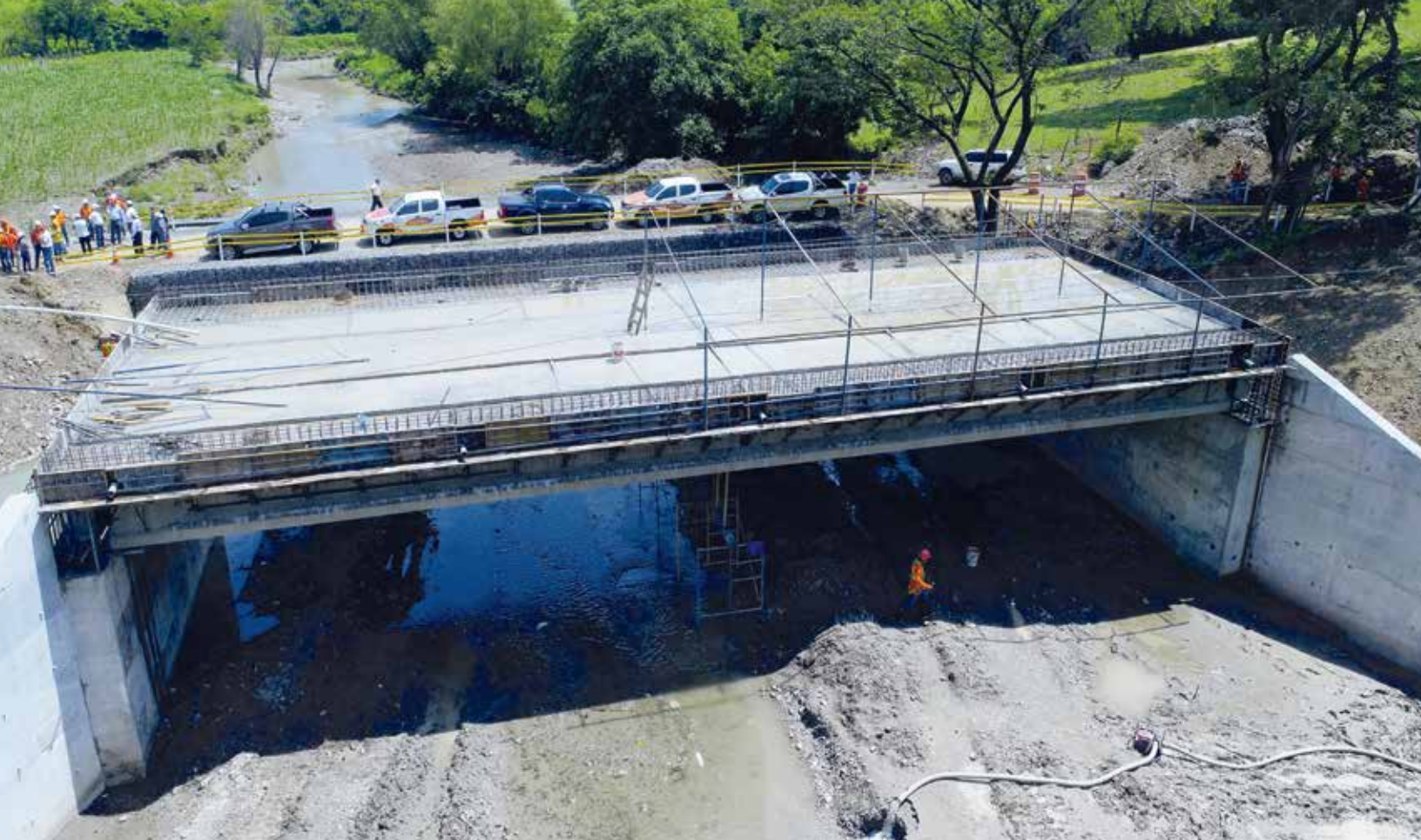
Puente Altina Cabañas. Ubicado en la ruta del Cerrón Grande, de 26.3 de longitud, asegurará la conectividad de Jutiapa e Ilobasco, Cabañas.
