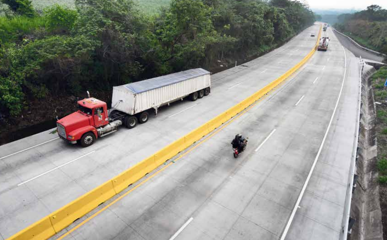
Carretera a Acajutla-Sonsonate. Corredor logístico que beneficia a más de 111,000 usuarios de la ruta.
