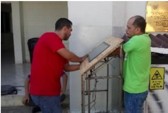
Foto: Construcción de la unidad de interpretación
