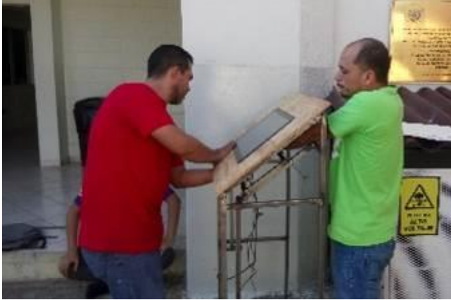
Foto: Construcción de la unidad de interpretación
